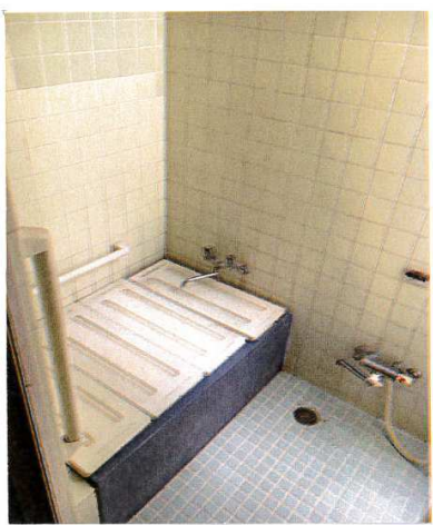
施工前の状態です。
